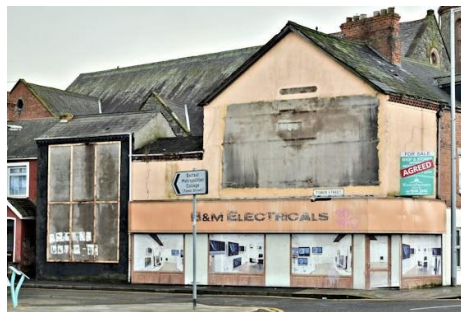
Leerstehende Gebäude sichern
