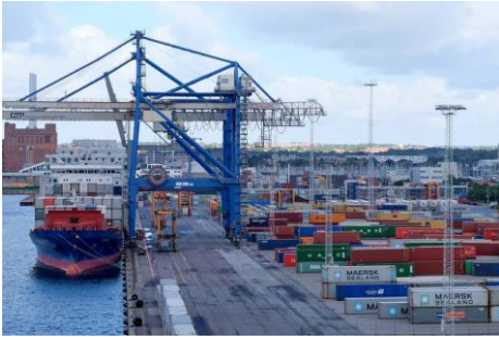
Sicherung von Industriebereichen
